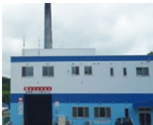
第1工場(焼却施設)
