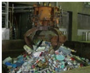
第2工場(破碎施設)
